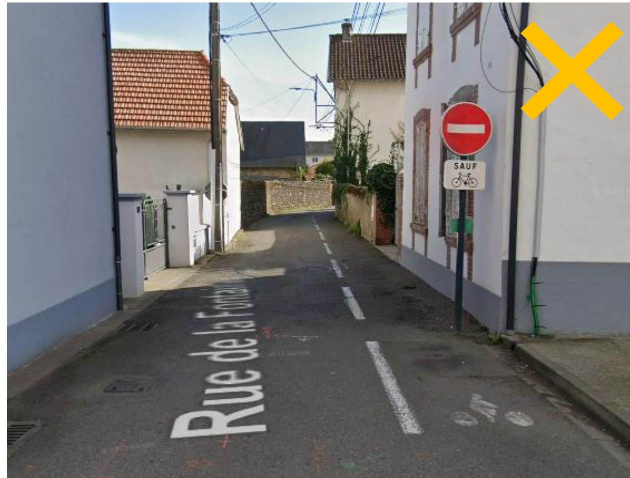
Rue de la Fontaine à Juillan, contre-sens cyclable au marquage non-réglementaire de la bande (T3 2u)
