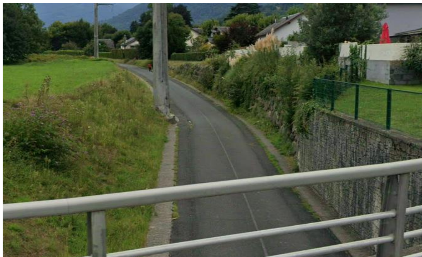
Voie verte en enrobé à Argelès-Gazost, entre Lourdes et Pierrefitte
