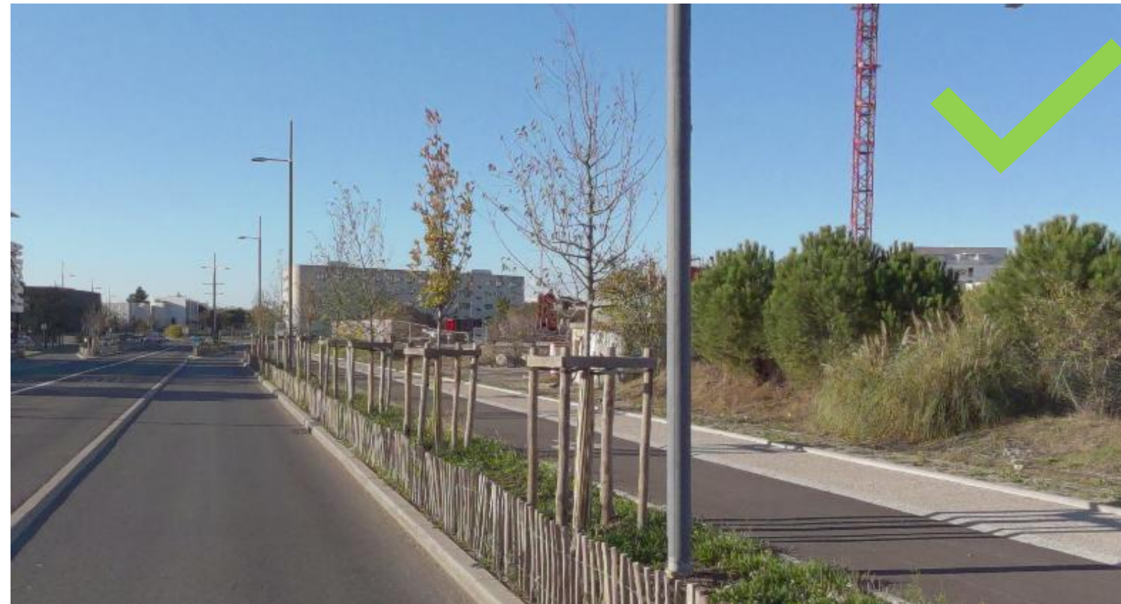
Piste cyclable unidirectionnelle en enrobé noir, trottoir d'une couleur différenciée, à Montpellier (34)
