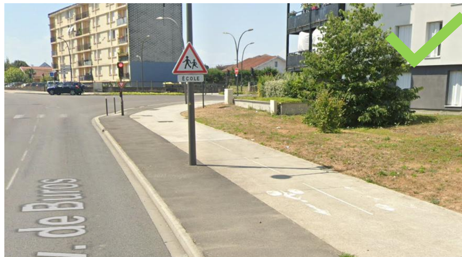
Piste cyclable sur trottoir d'une couleur différente, Avenue de Buros, à Pau (64)
